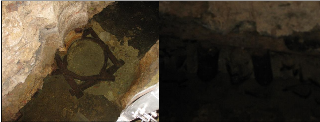
Figura 2.6: Grade de madeira (à esquerda) e parte das estacas de pinho verde remanescente de um edifício pombalino (à direita), cortesia do Núcleo Arqueológico Da Rua Dos Correiros.
